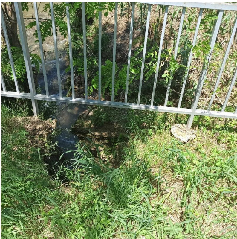
Imatge 5. L'aleta s'ha desplaçat i ha produït esvorancs a dalt el pont.
