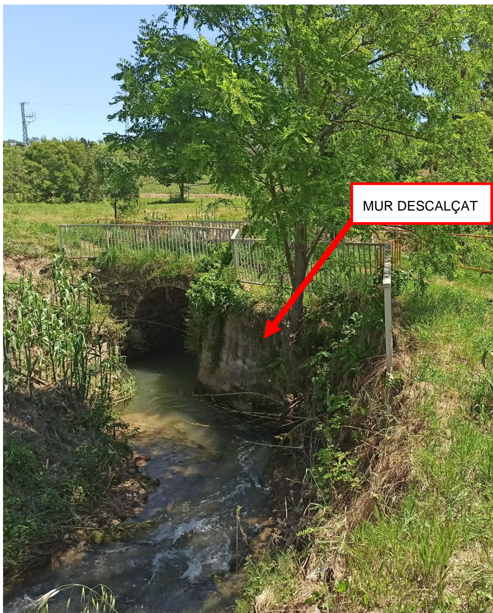
Imatge 2. Vista general cap a aigües avall del pont des del marge dret.
