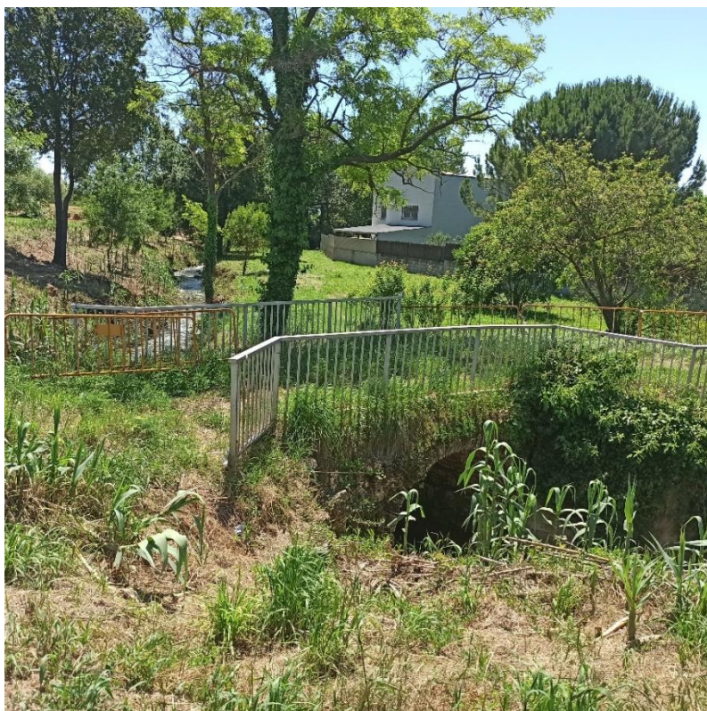
Imatge 6. Vista aigua avall del pont.
