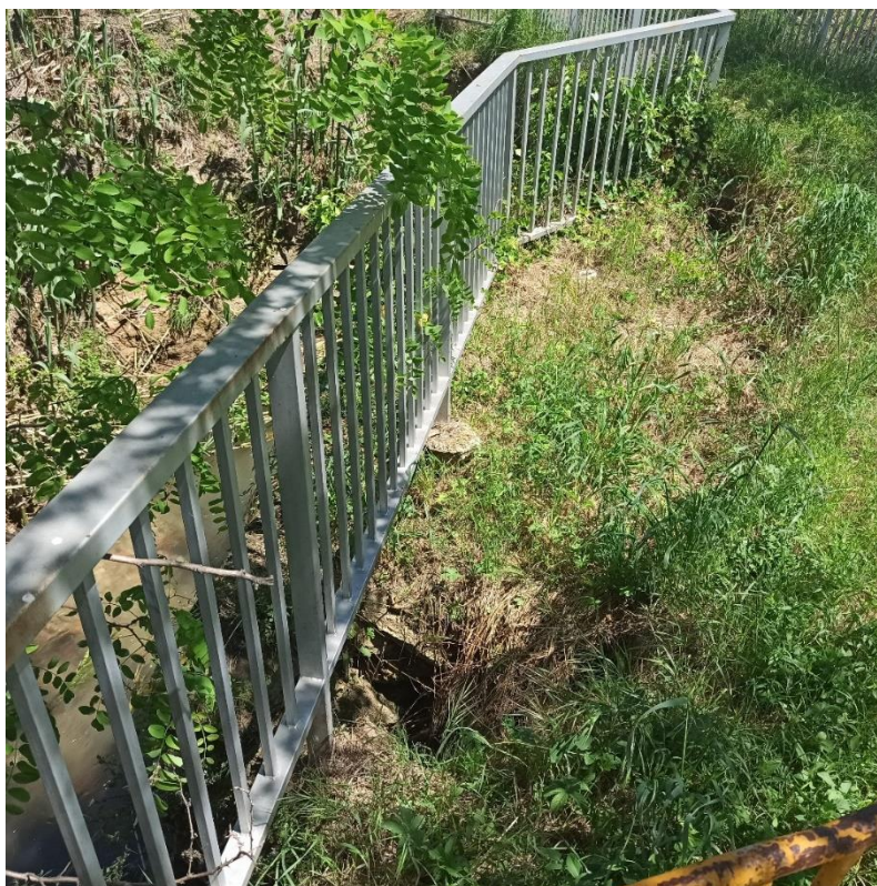
Imatge 4. Vista des de dalt del pont on s'observa que el terreny del trasdós de l'aleta s'ha esfondrat.
