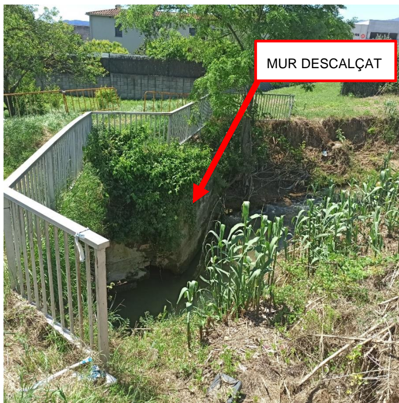
Imatge 3. Vista de la aleta del pont des del marge esquerre.
